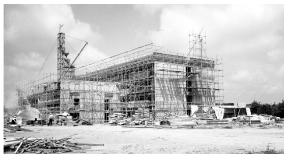
原子核工学科建設風景（青葉山、1965 年）
